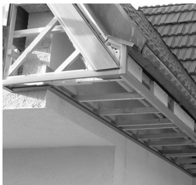
osazené ukonč. profily a první lamela
